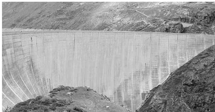
Le barrage de Moiry.
